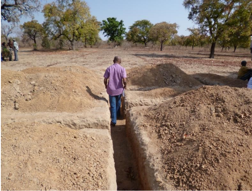
Erster Kontrollbesuch / Aushub der Fundamente
