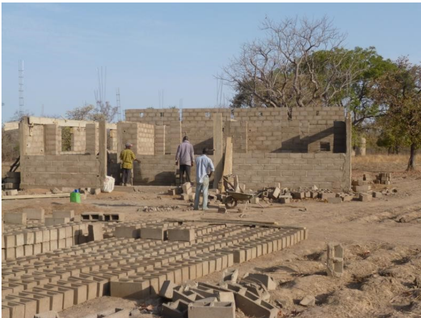
Zweiter Kontrollbesuch / Rohbau und selbst fabrizierte Betonziegel
